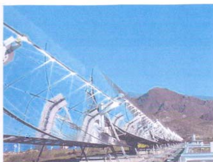
Parabolrinnen der Direct-Solar-Steam-Versuchsanlage auf der PSA Foto: Volker Quaschnig
