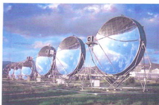
Dish/Stirling Versuchsanlagen auf dem Testgelände der PSA Foto: Wolfgang Reinalter
